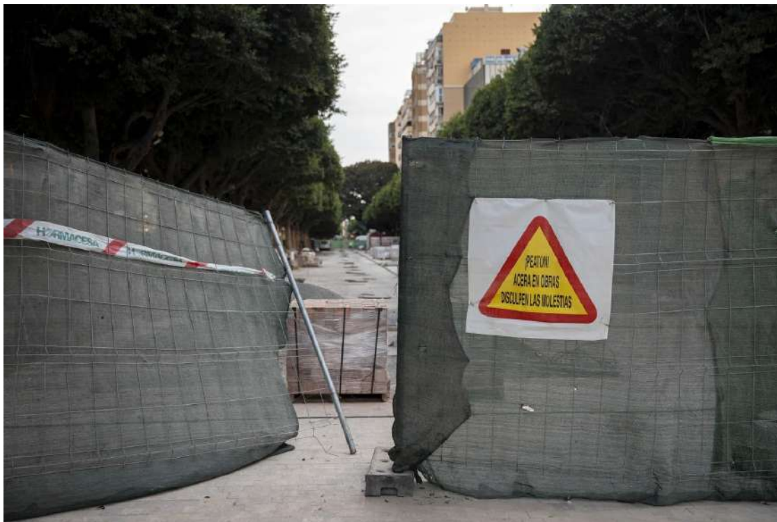
Paseo de Almería, en obras. / Marian León
