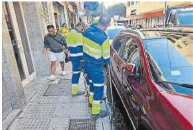
Operarios de Aqualia en la calle de Carlos V.
